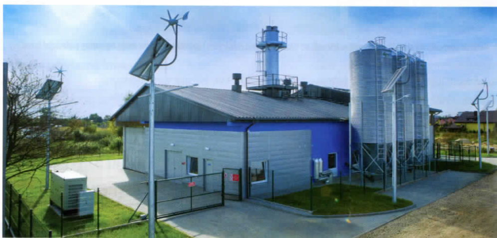
► Ciepłownia w Złoczewie o mocy 2,8 MW
